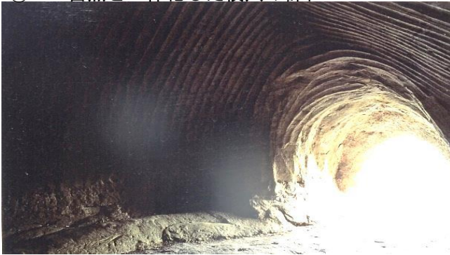
⑮-2 岩盤をくり抜いた横穴の内部から入口を見る
