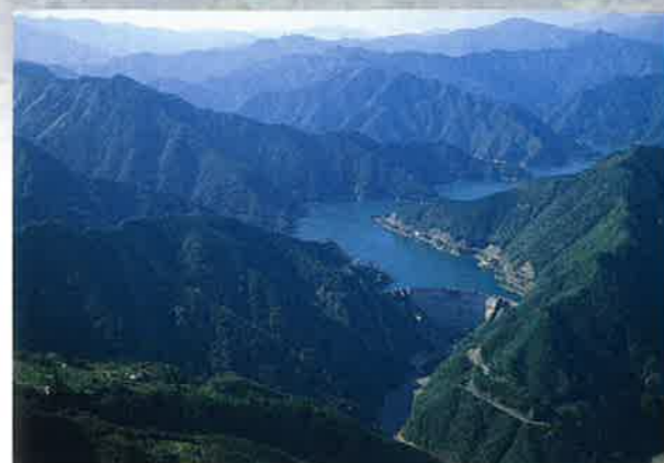
ひとつせ 一ツ瀬ダム 「九州最大の水ガメ」の愛称で知られる高さ130mのアーチ式ダムです。ダム湖の名は「米良湖」といいます。 C-3
