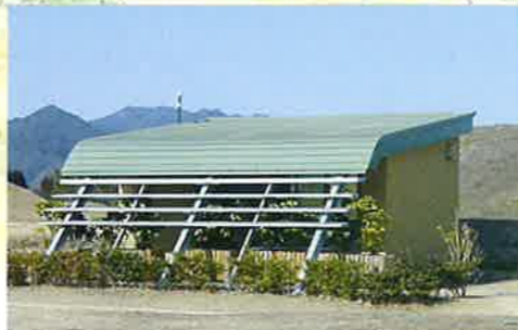
4号地下式横穴墓 111号墳の直下に位置し、玄室はこれまで確認されている中でも最大級の規模。カメラで玄室の内部を見ることができます。
